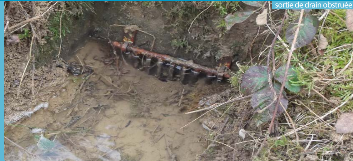
sortie de drain obstruée
