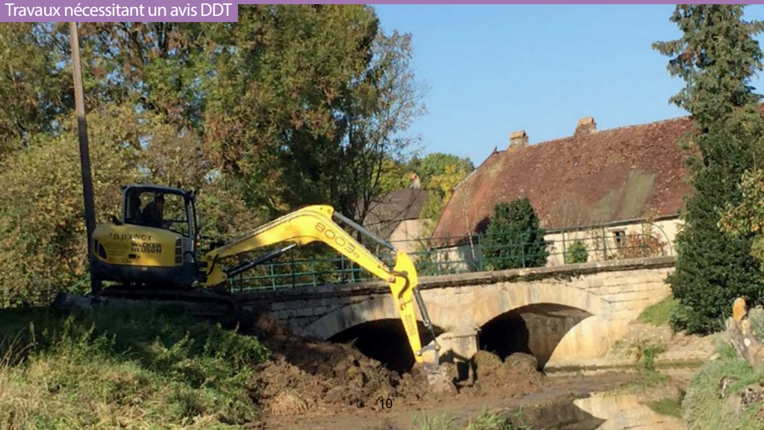
Travaux nécessitant un avis DDT
