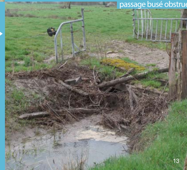
passage busé obstrué
